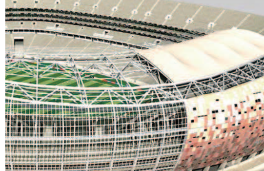
Installation einer Hallschmid-Fassade an der damals weltgrößten Stadionbaustelle für die WM 2010 in Südafrika
