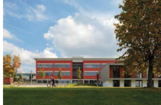
Schulgebäude Arnstorf: Hier ist auch die Ralschule untergebracht. Den Bauauftrag erledigte u.a. die Fa. Otteneder
