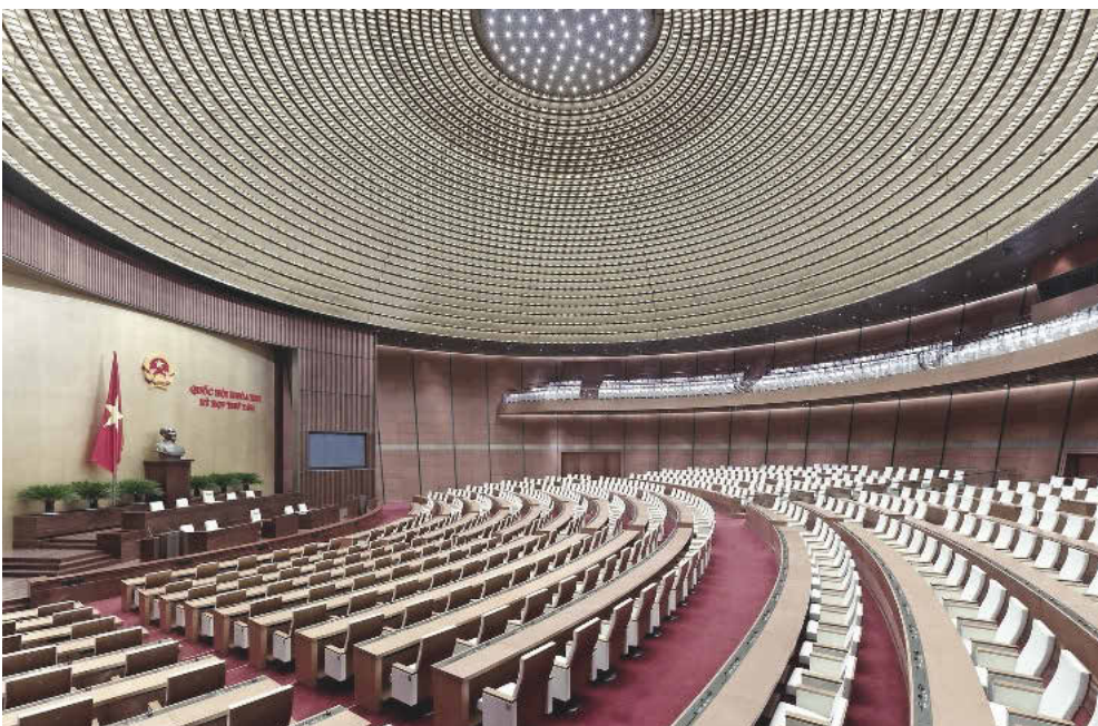
Für die Lichtkuppeldecke im Plenarsaal wurde auf 950 m 2 die Lichtdecke LMD-S als Sonderlösung verbaut.
