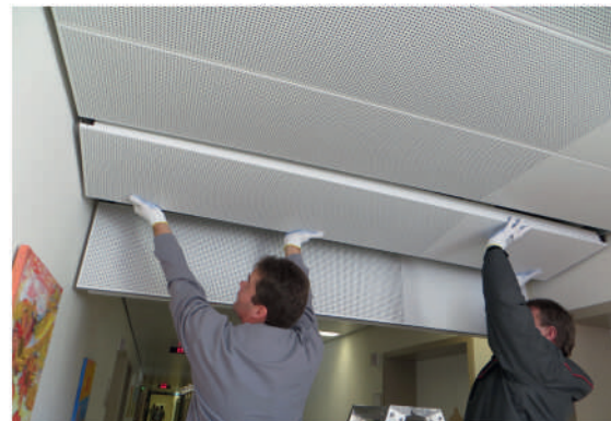
Die Lindner F30 Brandschutzunterdecken lassen sich werkzeuglos abklappen.
